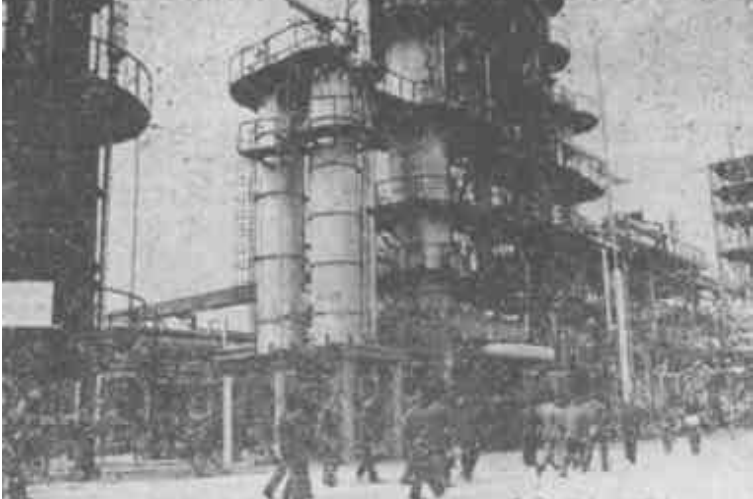
石油大学胜华炼油厂新建的催化裂化装置，日前竣工投产。该装置为石油二次加工，年处理量3万吨。为工厂的发展和学校的科研教学创造了良好条件。(韩进 摄影)
